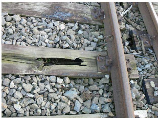
Obr.4 Pohled na stav železničního svršku v žst. Křenovice horní n.
