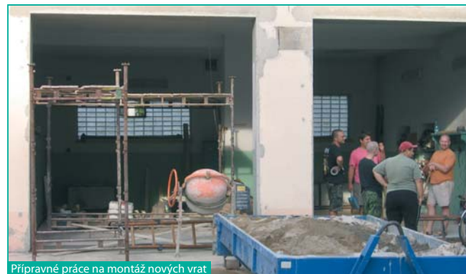
Přípravné práce na montáž nových vrat
