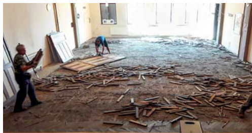
Odstraňování staré podlahy ze sálu Obecní hospody
