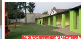
Přístřešek na zahradě MŠ Václavská
