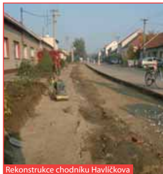
Rekonstrukce chodníku Havlíčkova
