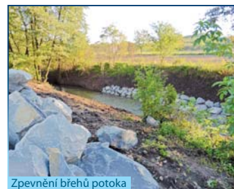
Zpevnění břehů potoka
