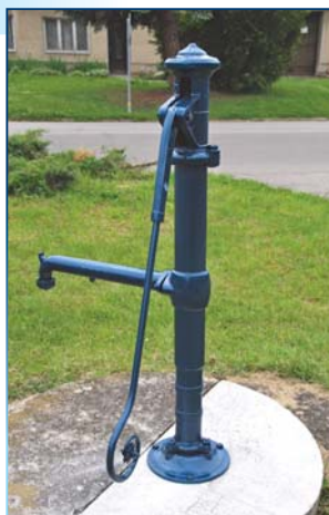
Nově osazená pumpa na Václavské ulici
