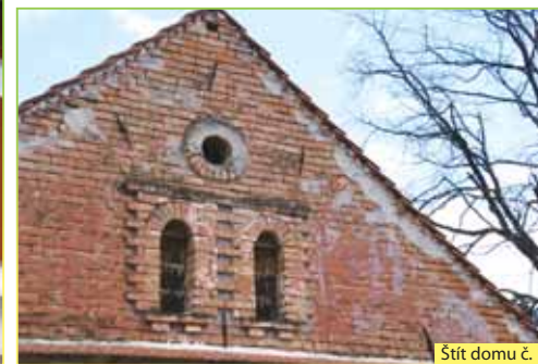
Štít domu č. 1
