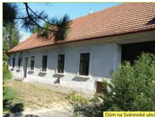
Dům na Svárovské ulici
